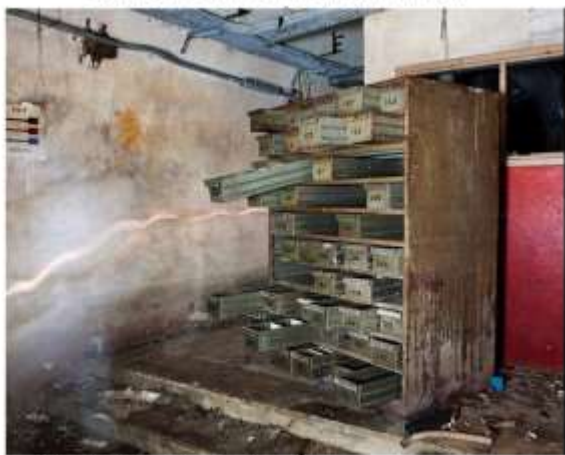
Quel che resta della sala comando.
